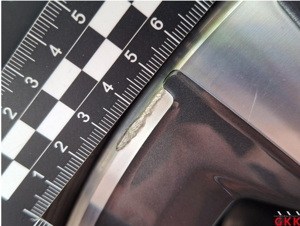
Bild 13. LM-Rad, hinten rechts, Materialabtrag, ersetzen
