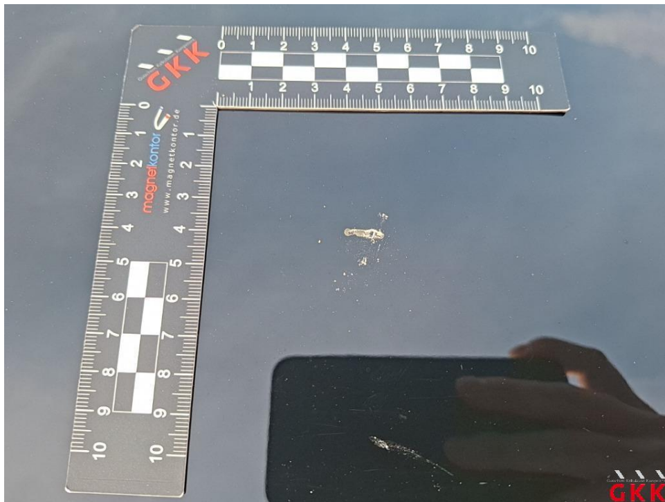
Bild 26. Dach, Harzanhaftungen/-rückstände, aufbereiten
