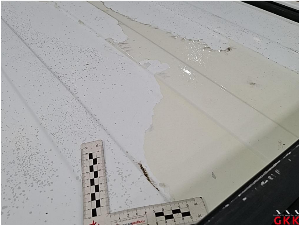
Bild 51. Kabinenaufbau hinten, Lackierung verätzt, lackieren
