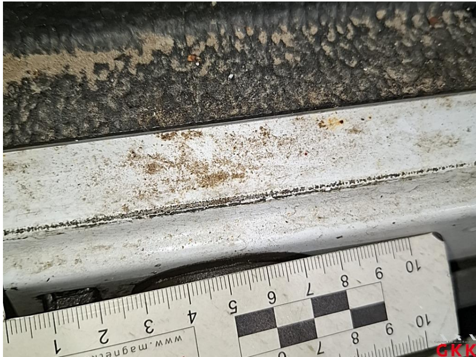
Bild 32. Ladekante, verkratzt, lackieren
