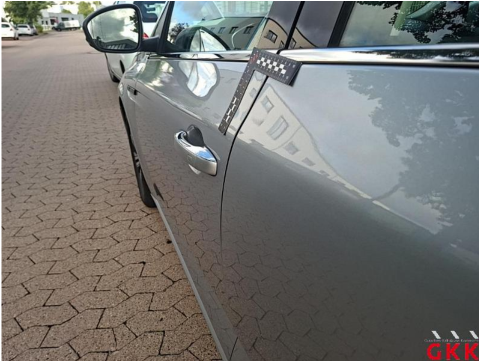
Bild 47. Tür hinten links Spaltmaß fehlerhaft, Reparaturmangel, einstellen
