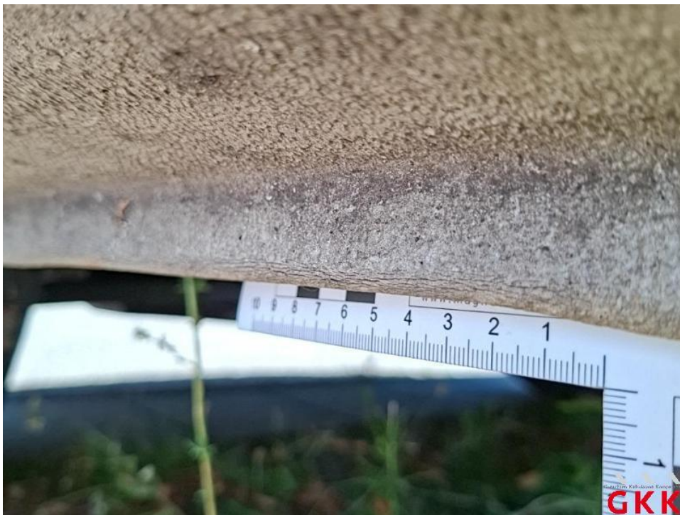
Bild 38. Schweller links, beschädigt, instand setzen - lackieren
