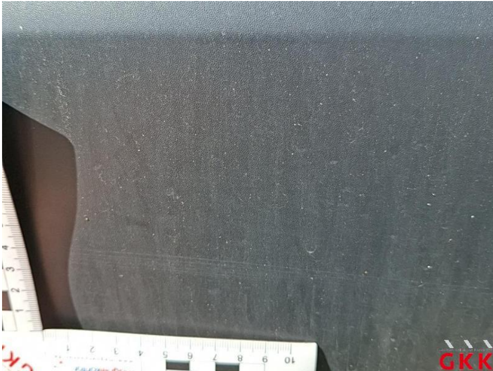
Bild 81. Seitenwand links, Leiste -unten-, verkratzt, ersetzen
