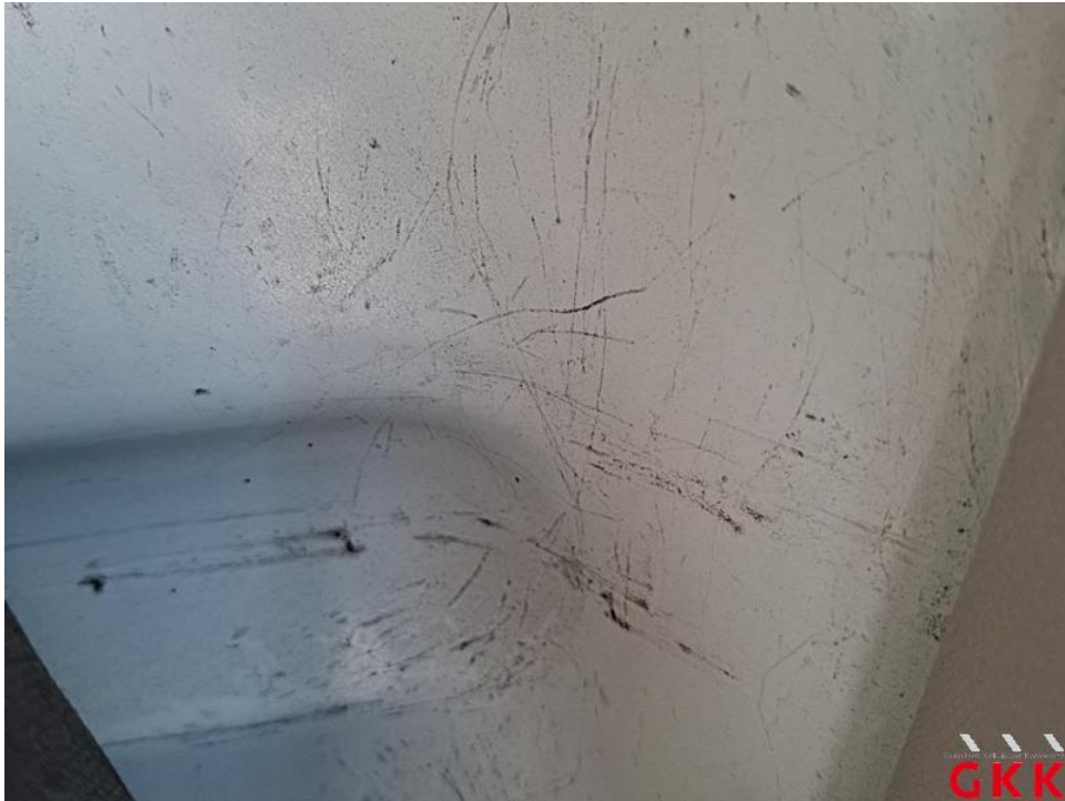
Bild 21. Trennwand, verkratzt, Smartrepair
