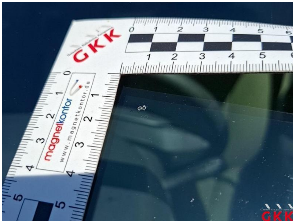
Bild 40. Frontscheibe, Steinschlag im Sichtfeld, ersetzen
