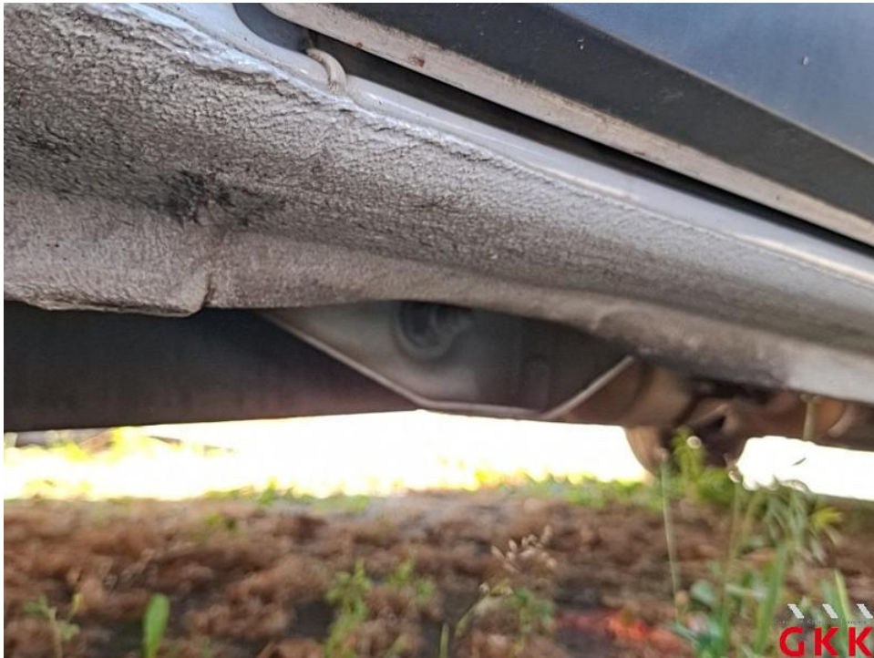
Bild 52. Schweller rechts, beschädigt, instand setzen - lackieren
