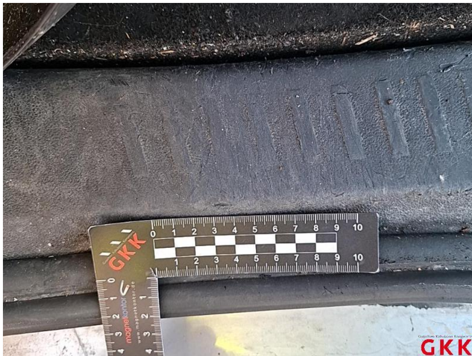
Bild 52. Ladekante, Abdeckung, verkratzt, ersetzen
