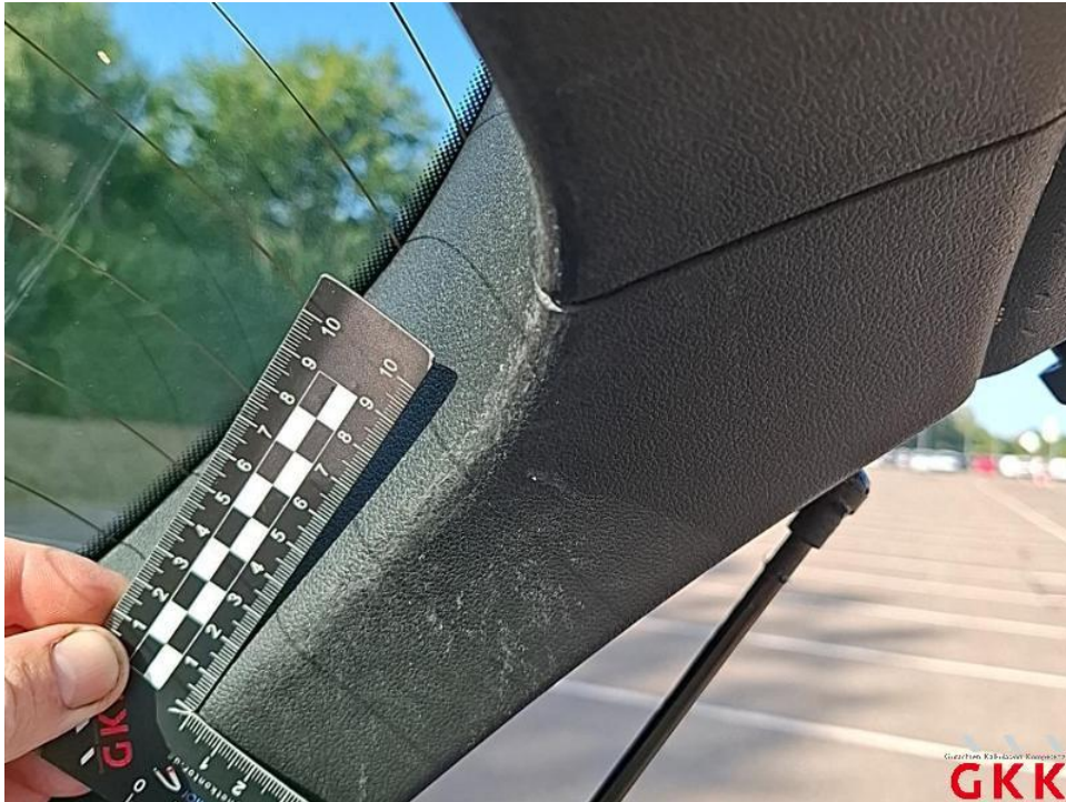
Bild 39. Heckklappe, Innenverkleidung, verkratzt, ersetzen
