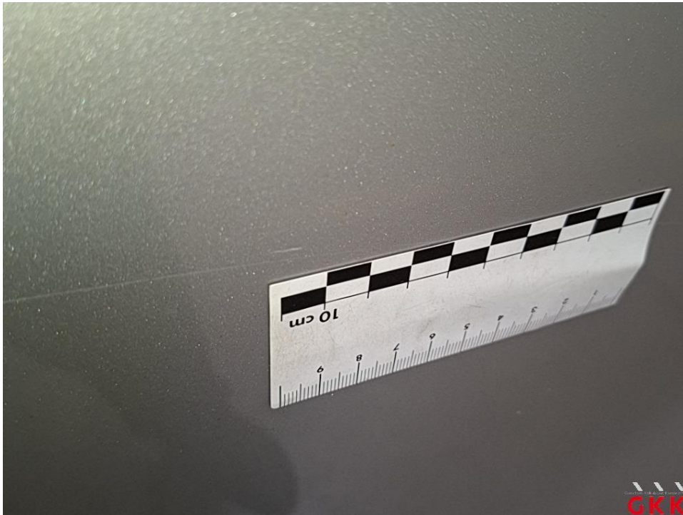
Bild 31 Seitenwand rechts, unterhalb, verkratzt, lackieren
