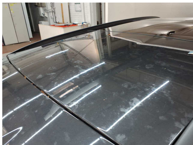
Damage 11: Roof: Roof (Verätzungen) - Paint defect - Paint
