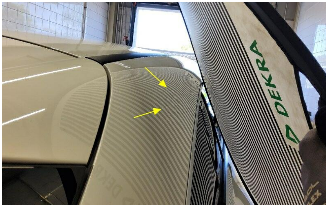
Bild 31 : Dachrahmen rechts, eingedellt, drücken
