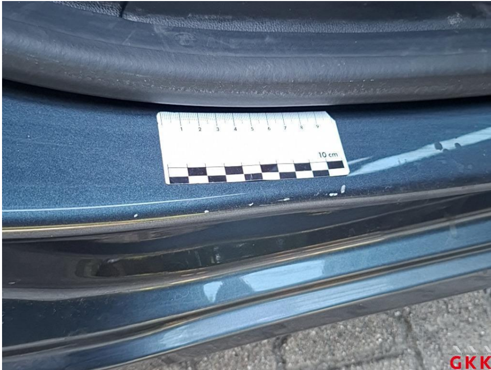
Bild 27. Tür hinten rechts, Einstieg, verkratzt, auslegen, schleifen, polieren
