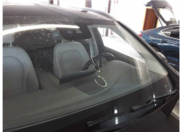
Beschädigung #7: Verglasung: Frontscheibe (Rissbildung) - Steinschlag - erneuern
