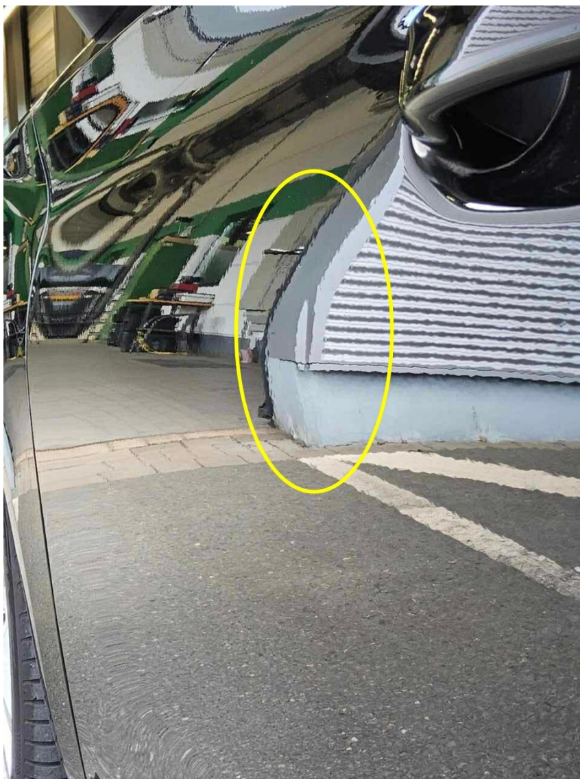
Bild 30 : Tür vorne links, eingedellt, instandsetzen und lackieren mit Lackaufbau
