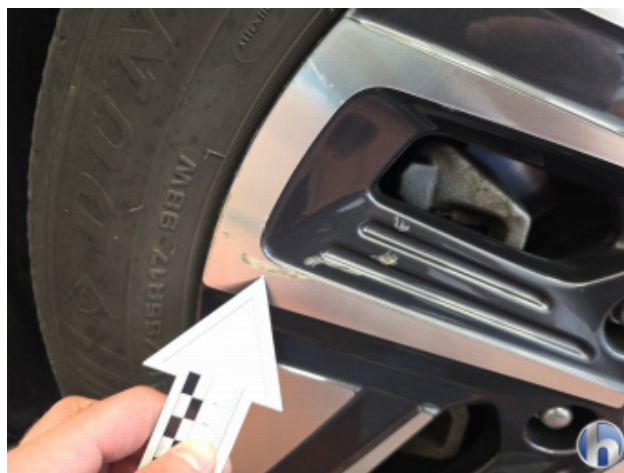
2. Felge Vorne - Links Kratzer - Smart Repair
