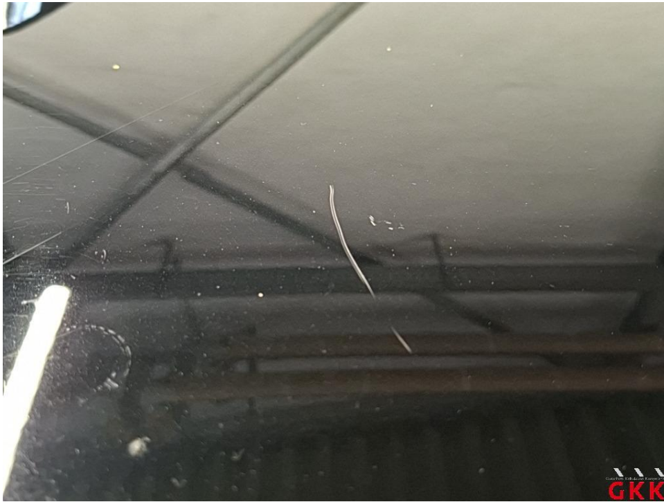
Bild 56 Dach, verkratzt, lackieren
