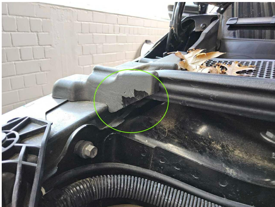
Bild 15 : Tierverschiss Motorraum, Schaumstoffecken erneuern
