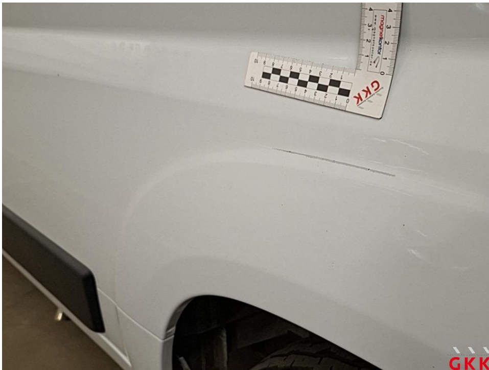
Bild 20 Seitenwand links, beschädigt, instand setzen - lackieren
