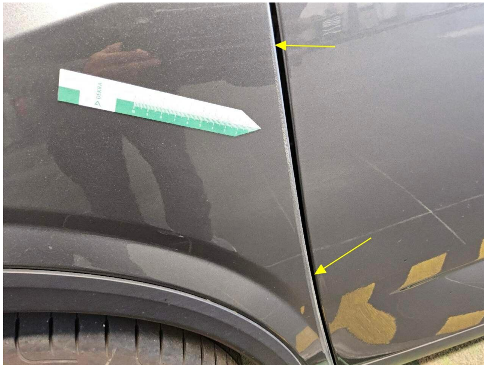
Bild 19 : Ringsum instandgesetzt/nachlackiert außer Dachholm links und rechts, nicht sach- und fachgerecht instandgesetzt/ nachlackiert
