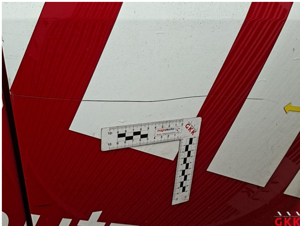
Bild 20. Schiebetür rechts, verkratzt, lackieren
