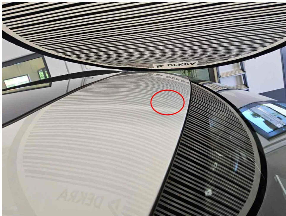
Bild 13 : Dach, eingedellt, Gebrauchsspur
