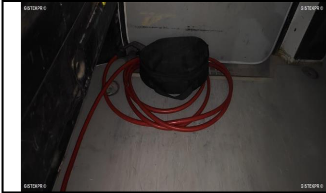
Foto daños internos 1
