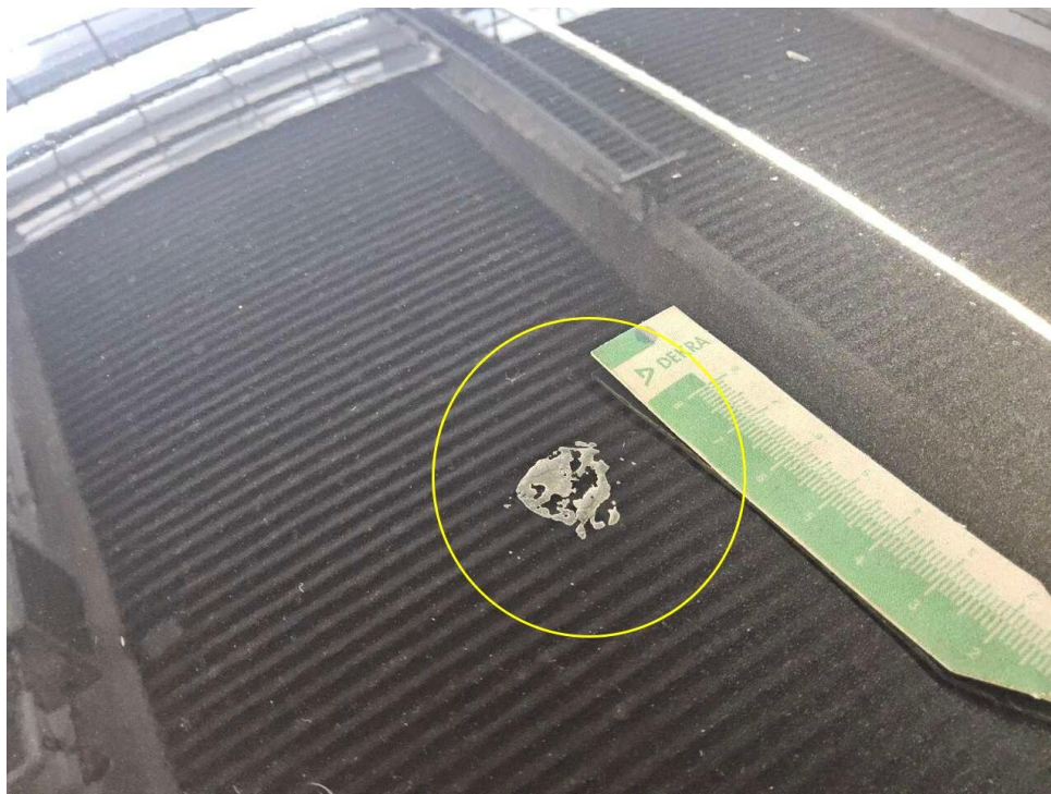
Bild 21 : Dach Lackierung, Umweltschaden, lackieren mit Lackaufbau
