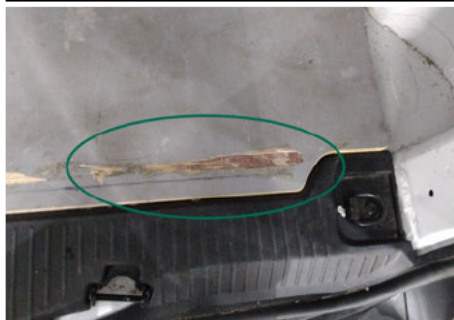
Holzboden / Hinten / Abgewetzt
