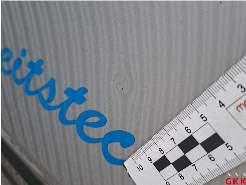
Bild 33. Tür vorne links, beschädigt, instand setzen - lackieren
