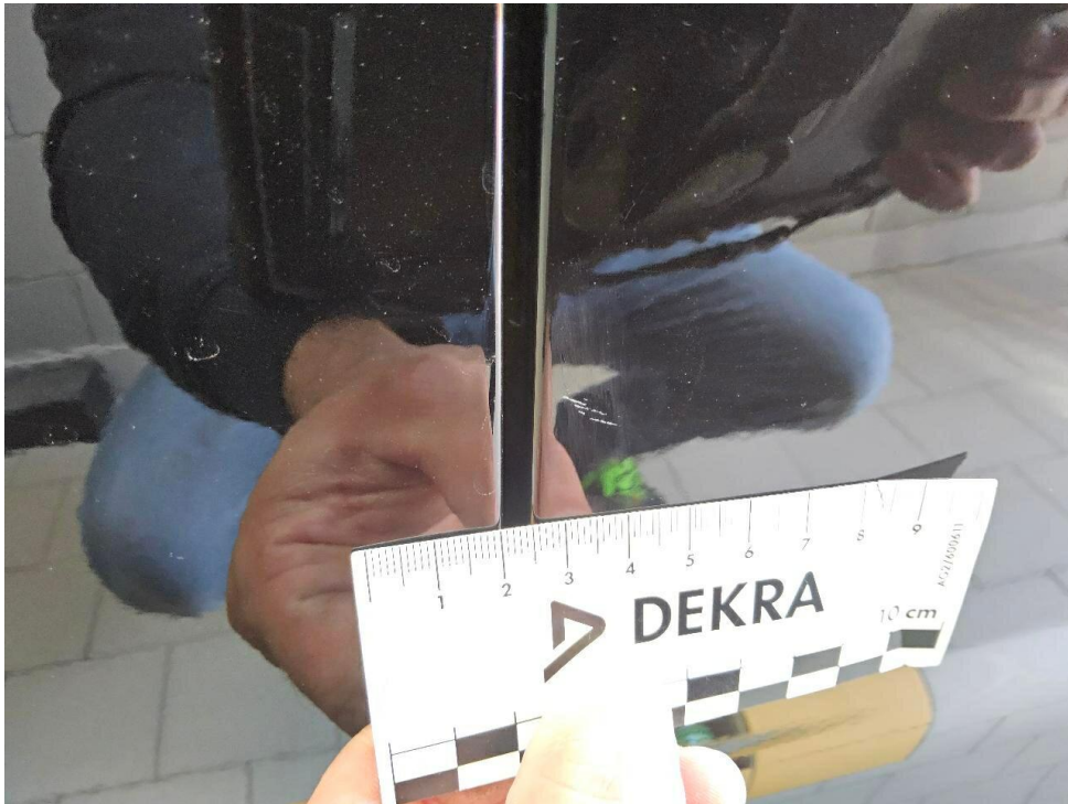
Bild 15 : Anhaftung an der Tür hinten links Anfatung an der Tür hinten links
