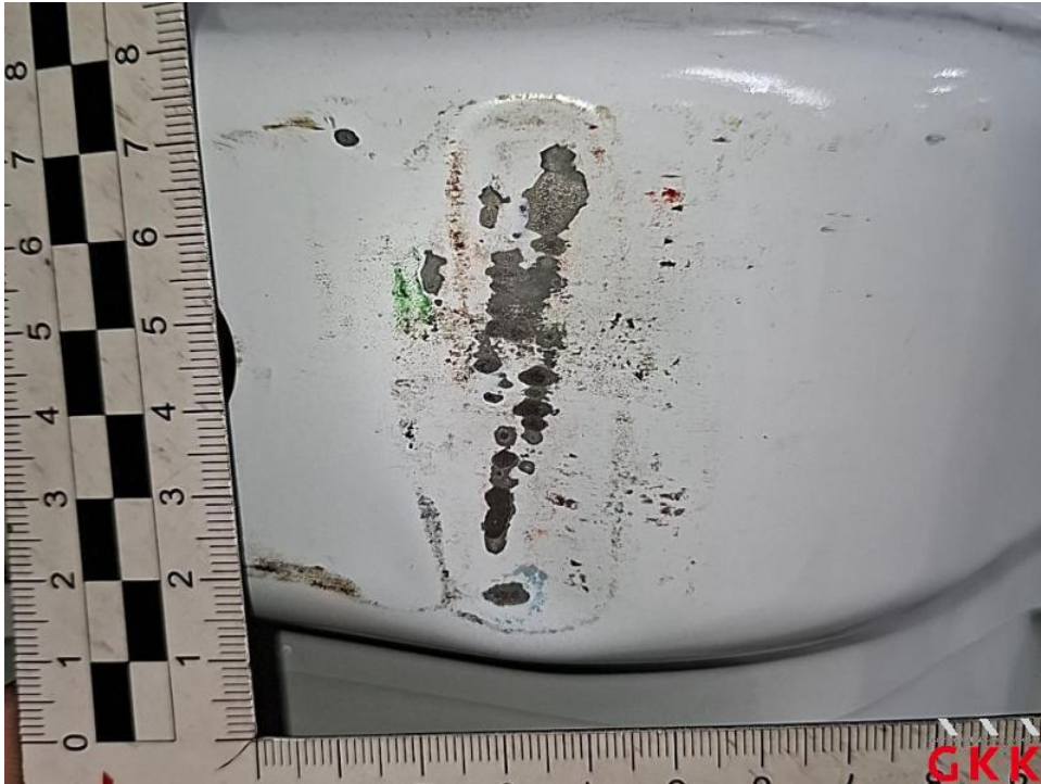
Bild 65. Trennwand, beschädigt, instand setzen - lackieren
