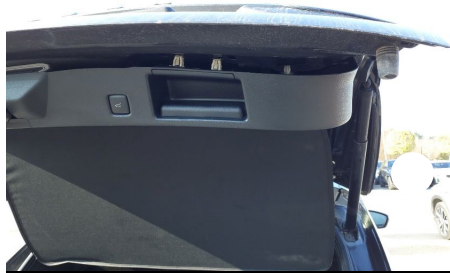
Rivestimento interno bagagliaio / Posteriore / Non conforme
