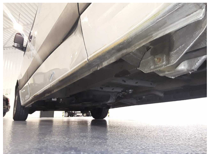
Beschädigung 19: Schweller links: Schweller - verformt - erneuern
