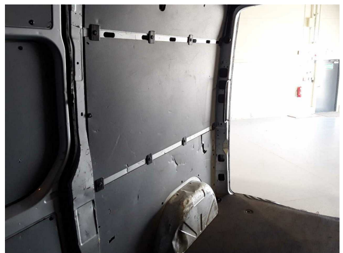
Beschädigung 3: Verkleidungen/Abdeckungen: Laderaumverkleidung rechts - beschädigt - erneuern
