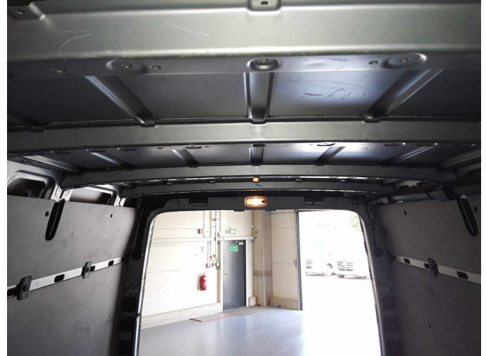
Beschädigung 7: Koffer: Dachquerstrebe - lose - instandsetzen und lackieren
