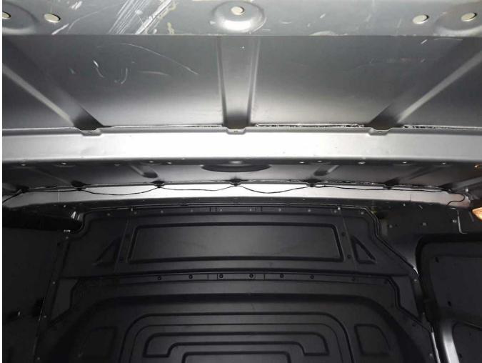
Beschädigung 7: Koffer: Dachquerstrebe - lose - instandsetzen und lackieren
