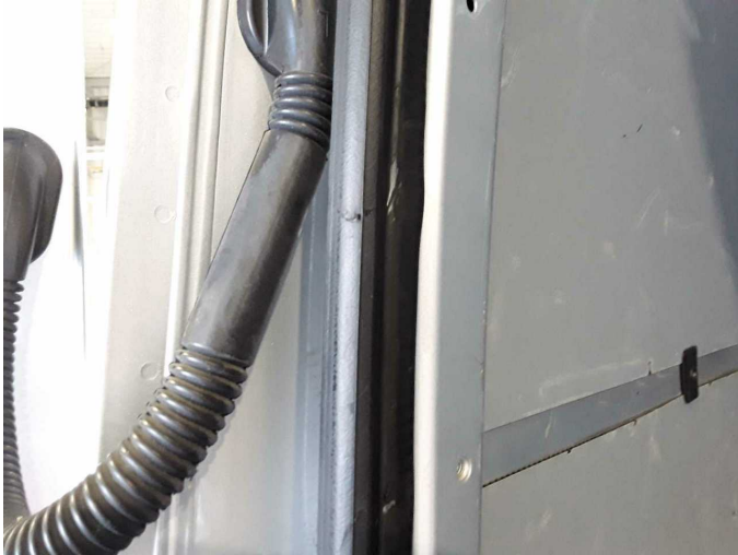
Beschädigung 13: Karosserie: Dichtung Heckdeckel /-tür - beschädigt - erneuern
