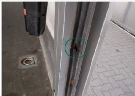
Dichtung Türeinstieg / Hinten Rechts / Gebrochen
