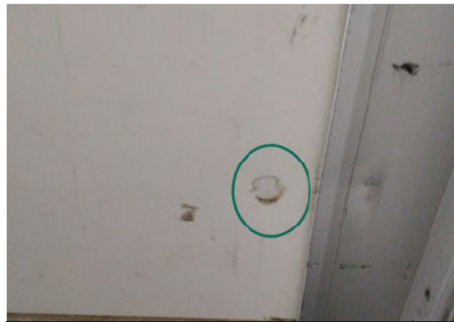
Seitenwand / Links / Gebrochen
