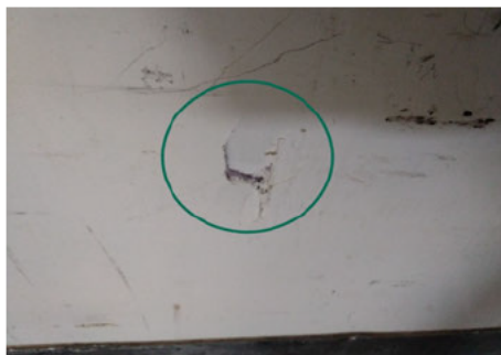
Seitenwand / Vorne / Gebrochen
