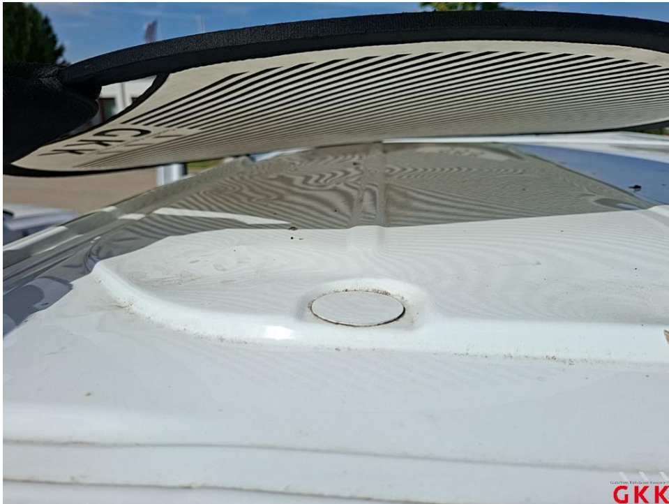
Bild 17 Dach, beschädigt, ersetzen
