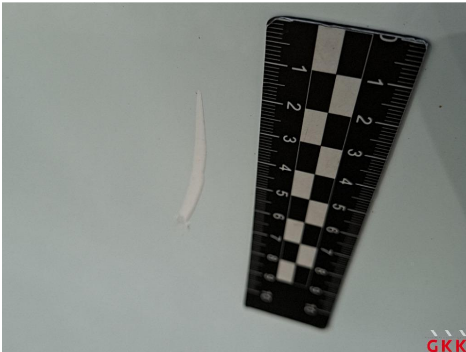
Bild 30 Schiebetür rechts, Lackierung verätzt, aufbereiten
