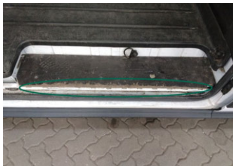
Holzboden / Rechts / Abgewetzt
