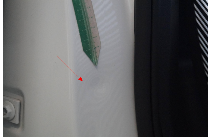
Bild 2: Außen, Tür vorne rechts - Einstieg, eingedellt, drücken
