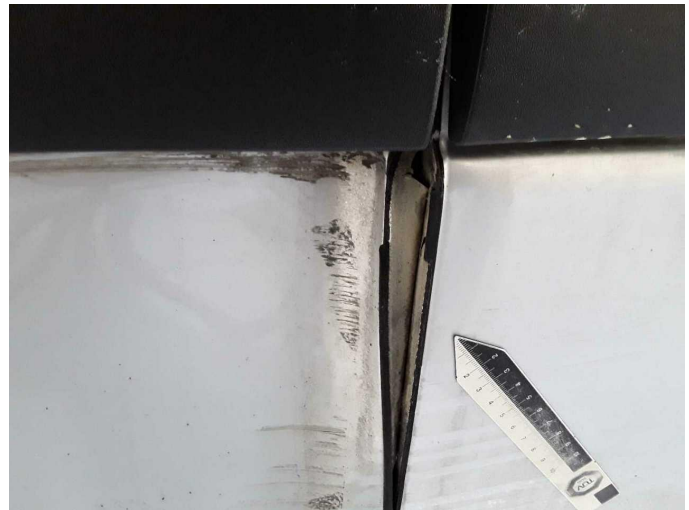
Beschädigung 29: Schweller links: Schweller - verformt - erneuern
