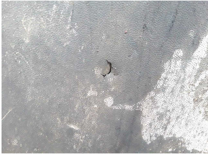
Beschädigung 8: Interieur: Laderaumboden - beschädigt - instandsetzen
