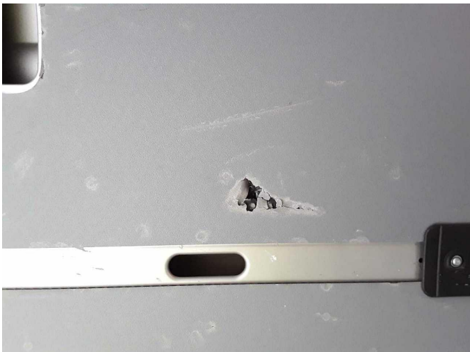
Beschädigung 4: Verkleidungen/Abdeckungen: Laderaumverkleidung rechts - beschädigt - erneuern
