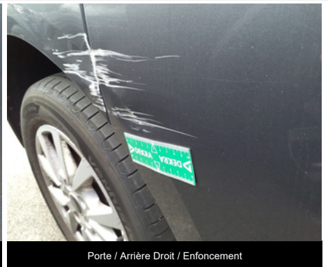
Porte / Arrière Droit / Enfoncement
