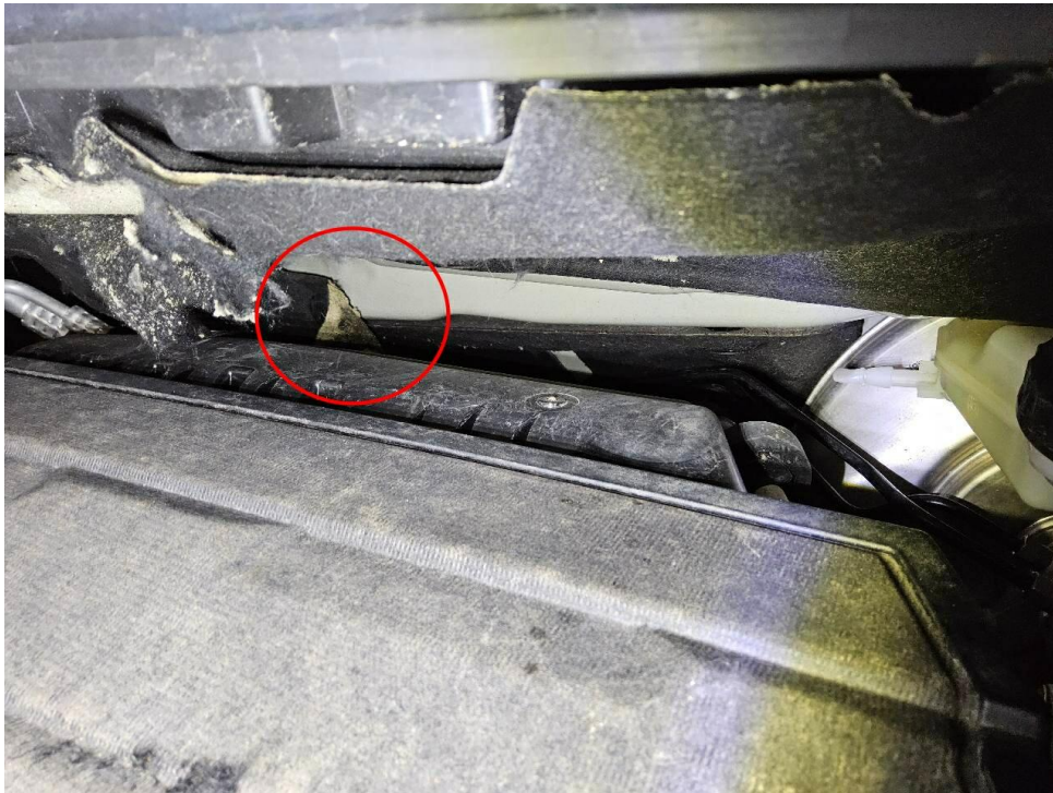
Bild 15 : Motordämmmatte und Dämmung Stirnwand gerissen
