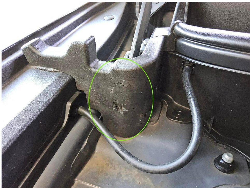
Bild 9 : Tierversbiss Motorraum, Schaumstoffecken erneuern
