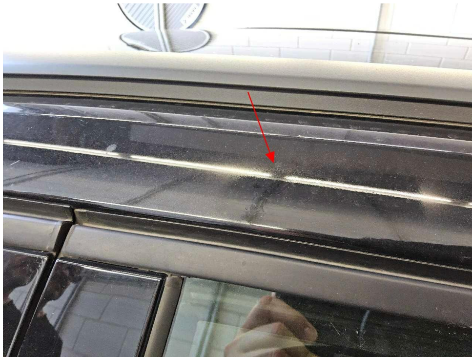
Bild 22 : Dachholm, Dach Lackverätzungen
