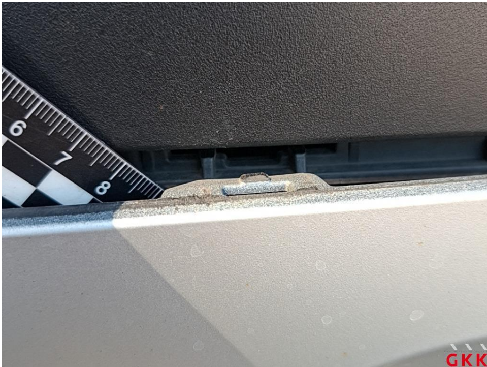
Bild 18. Stoßfänger hinten, Leiste -mittig-, beschädigt, ersetzen
