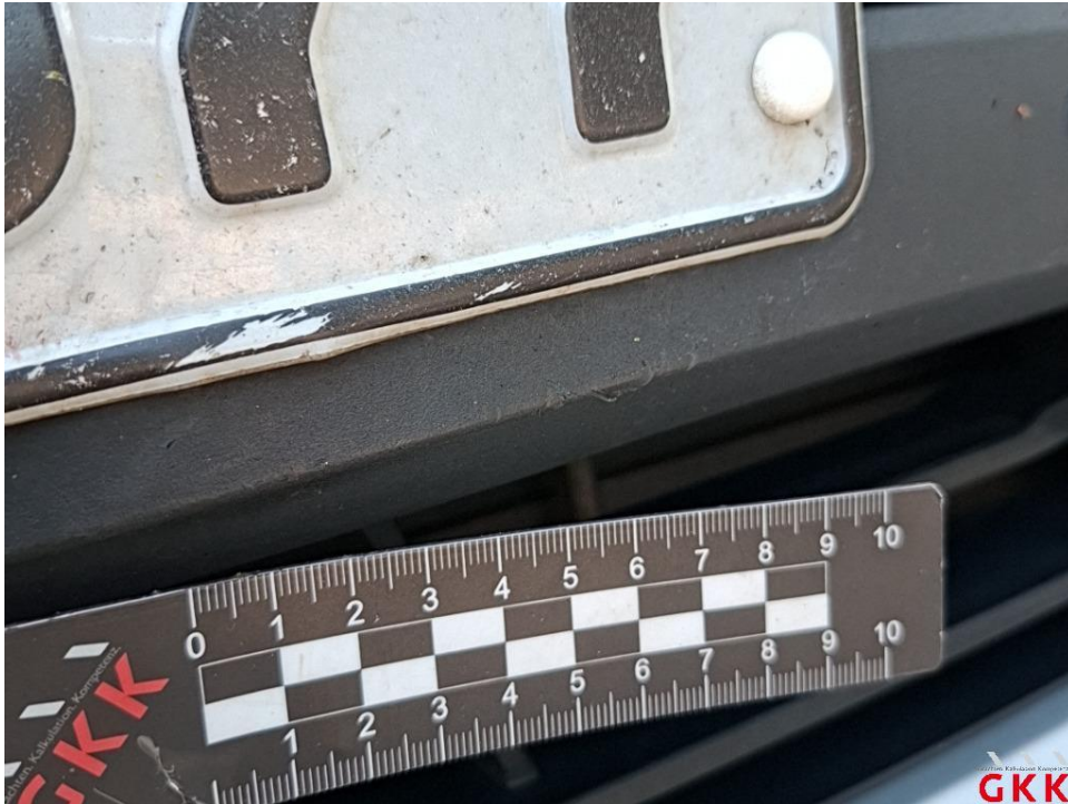
Bild 29. Stoßfänger vorne, Leiste -mittig-, beschädigt, ersetzen
