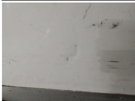
Seitenwand / Links / Gebrochen
