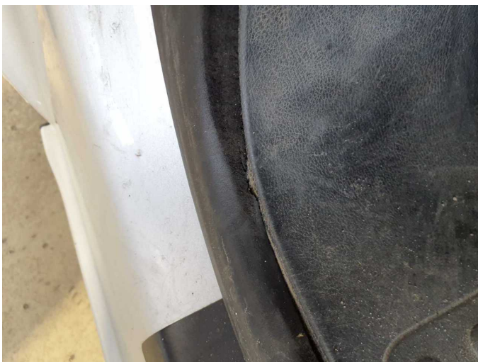
Damage 5: Door - front left side: Door seal - Broken / torn - Replace
