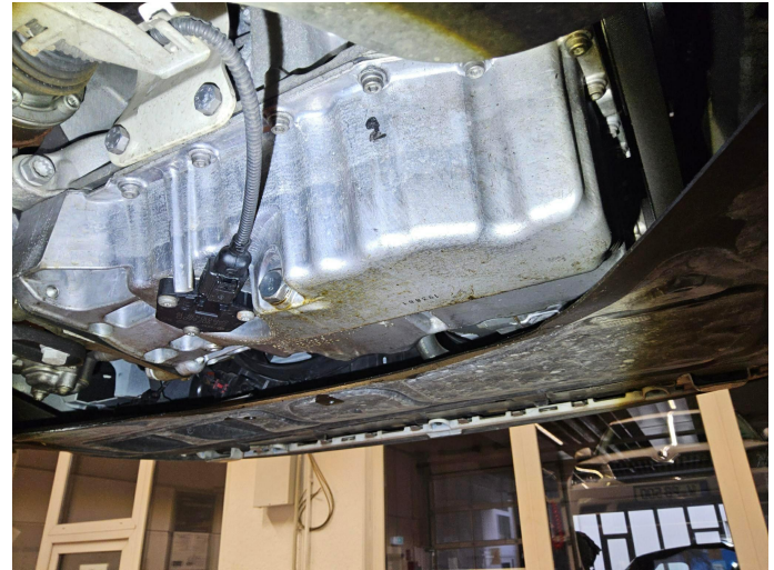
Bild 18: Technik, Motor, undicht, prüfen und Befund festlegen, Schaden- erweiterung möglich
