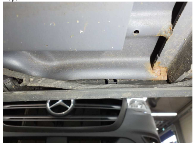
Beschädigung #3: Stossfänger hinten: Träger Stossfänger Auftritt mit Parktronic - verformt - Smart Repair
