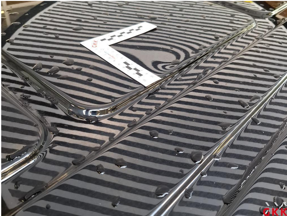
Bild 18 Dach, beschädigt, instand setzen - lackieren
