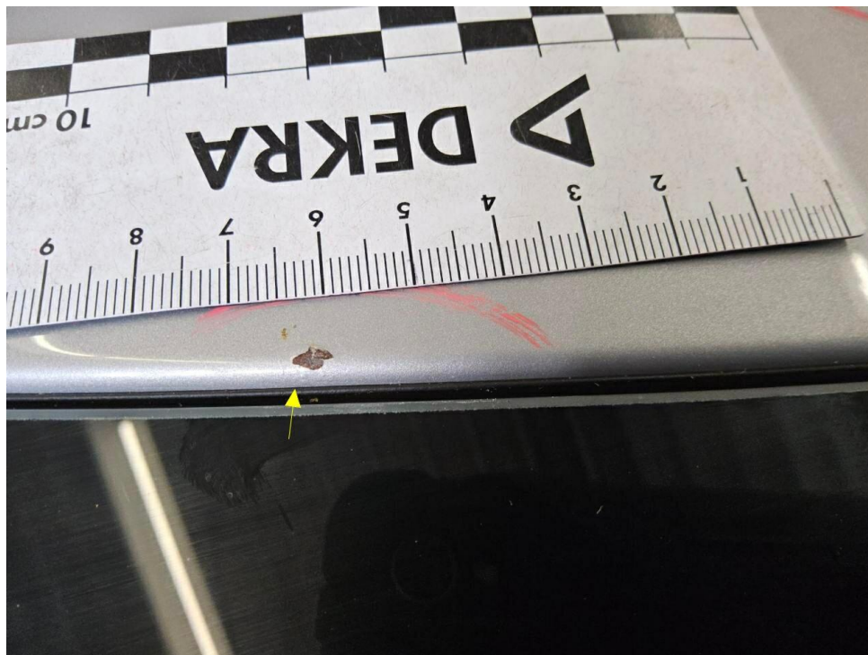
Bild 15 : Dach, korrodiert, lackieren mit Lackaufbau
