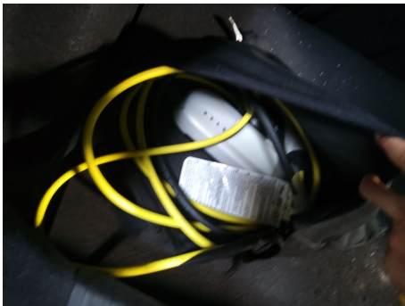
Cable de carga rápida / - / Faltante
