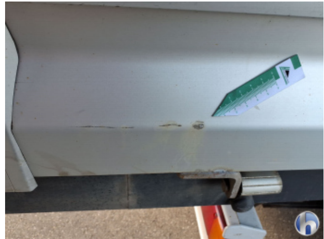
1. Seitenwand - Hinten - Links Beschädigt - Instandsetzen und Lackieren
