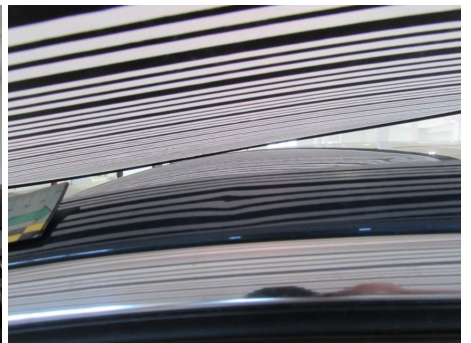
Montante tetto / Sinistro / Rientranza da Grandine
