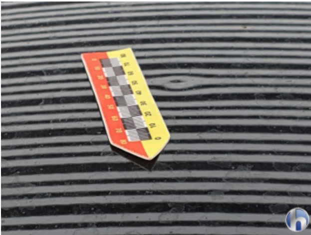
5. Dach 2 Dellen - Sanft Instandsetzen
