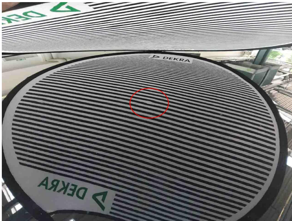
Bild 30 : Dach. mehrfach gedellt und Umweltschäden
