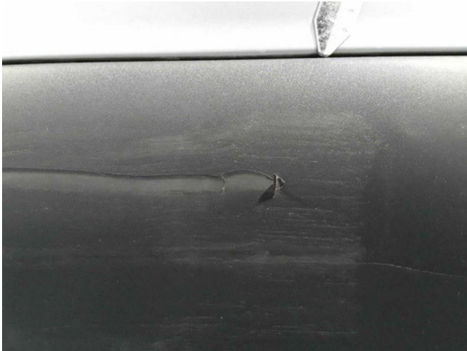
Beschädigung 10: Seitenwand links: Schutzleiste - beschädigt - erneuern
