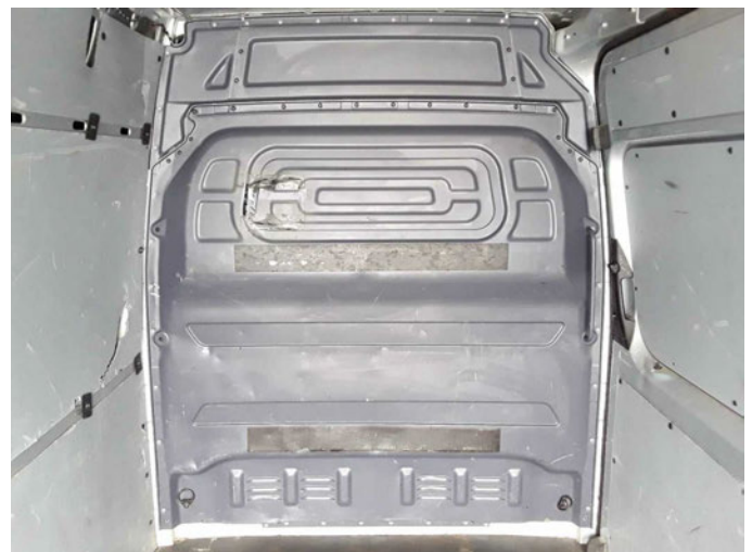
Beschädigung 4: Fahrerhaus: Rückwand - beschädigt - erneuern
