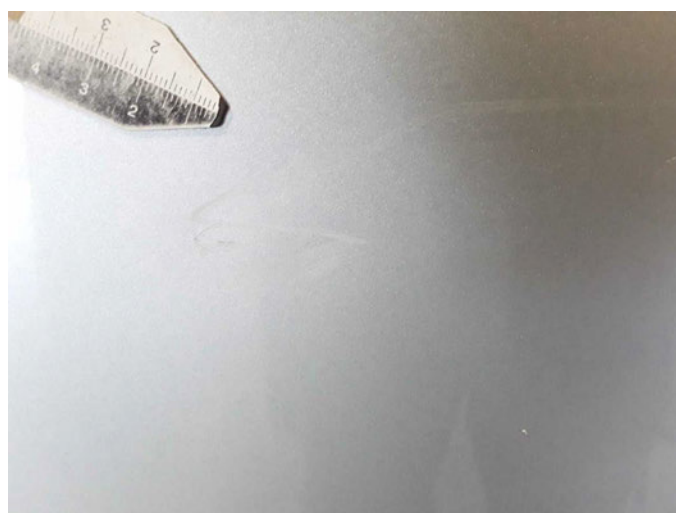
Beschädigung 18: Seitenwand rechts: Seitenwand - verformt - instandsetzen/lackieren (S3)
