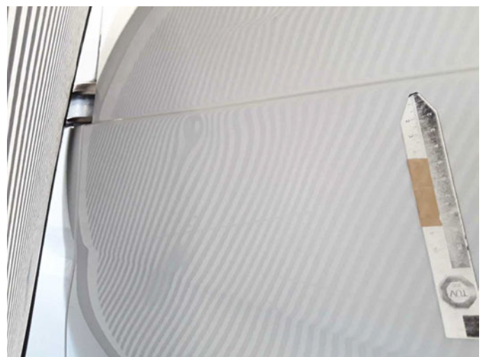
Beschädigung 19: Schiebetür rechts: Schiebetür - verformt - erneuern
