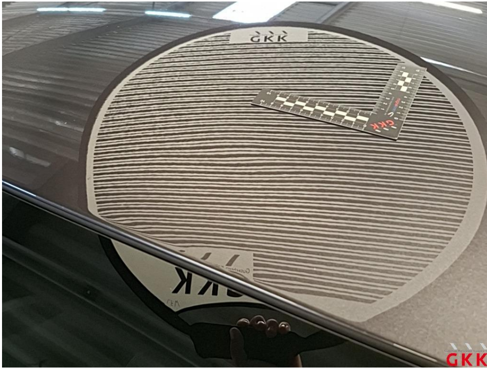
Bild 17 Dach, beschädigt, instand setzen - lackieren
