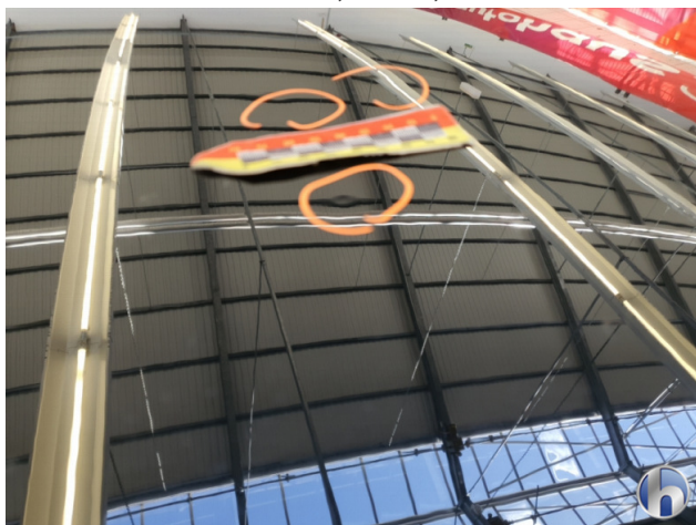
15. Dach Delle Bis 20 Mm Ohne Lackschaden - Sanft Instandsetzen 414,00 € / 414,00 €
